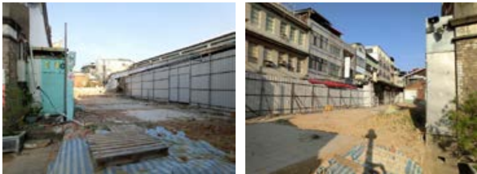
圖2-2苗栗文昌祠原左、右廂房拆除後照片(2018年9月21日拍攝)
