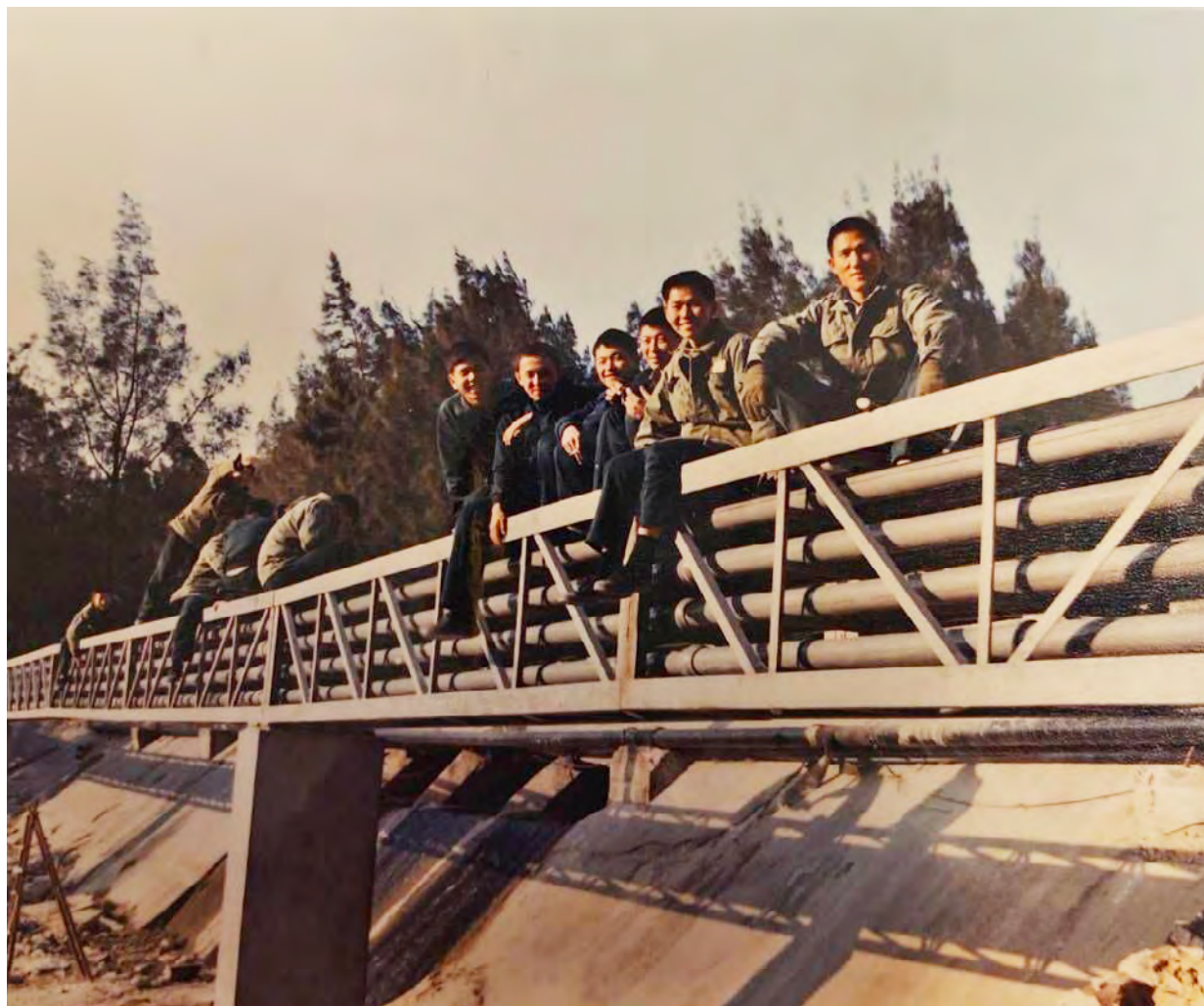
作者劉耀華（右）與軍中同袍鋪設纜線施工合照
